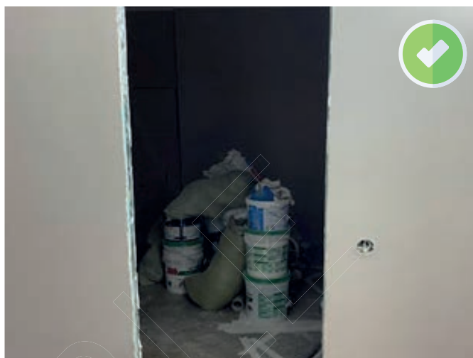
Готовый ровный проем для установки
