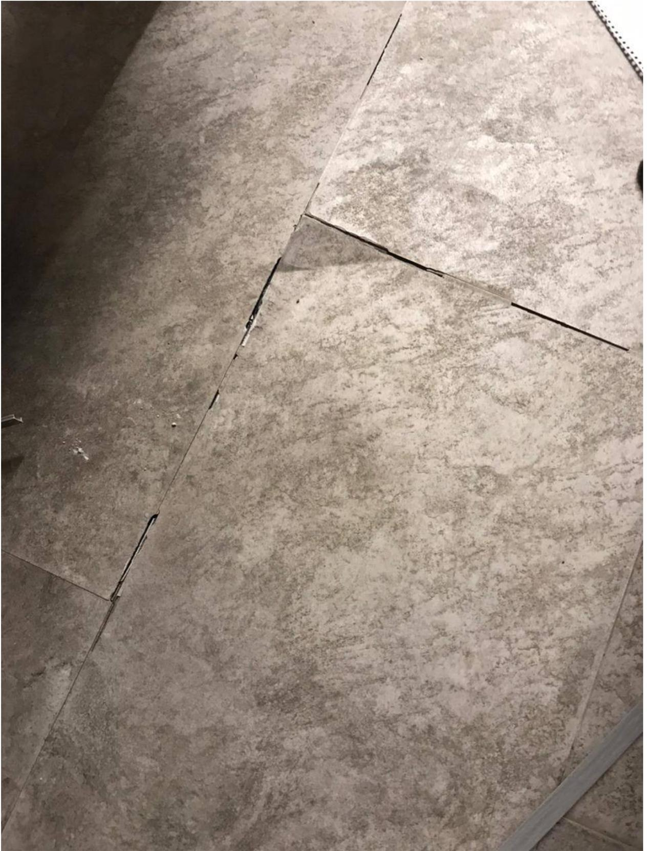
К сожалению, именно к таким серьезным последствиям приводит игнорирование инструкции производителя в части применения полиэтиленовой пленки. Химическая коррозия может привести к полному разрушению кварц-винила и сделает невозможным дальнейшую эксплуатацию напольного покрытия.
